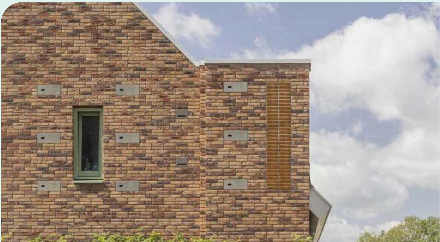
Onderbreking dakhelling met detail metselwerk
