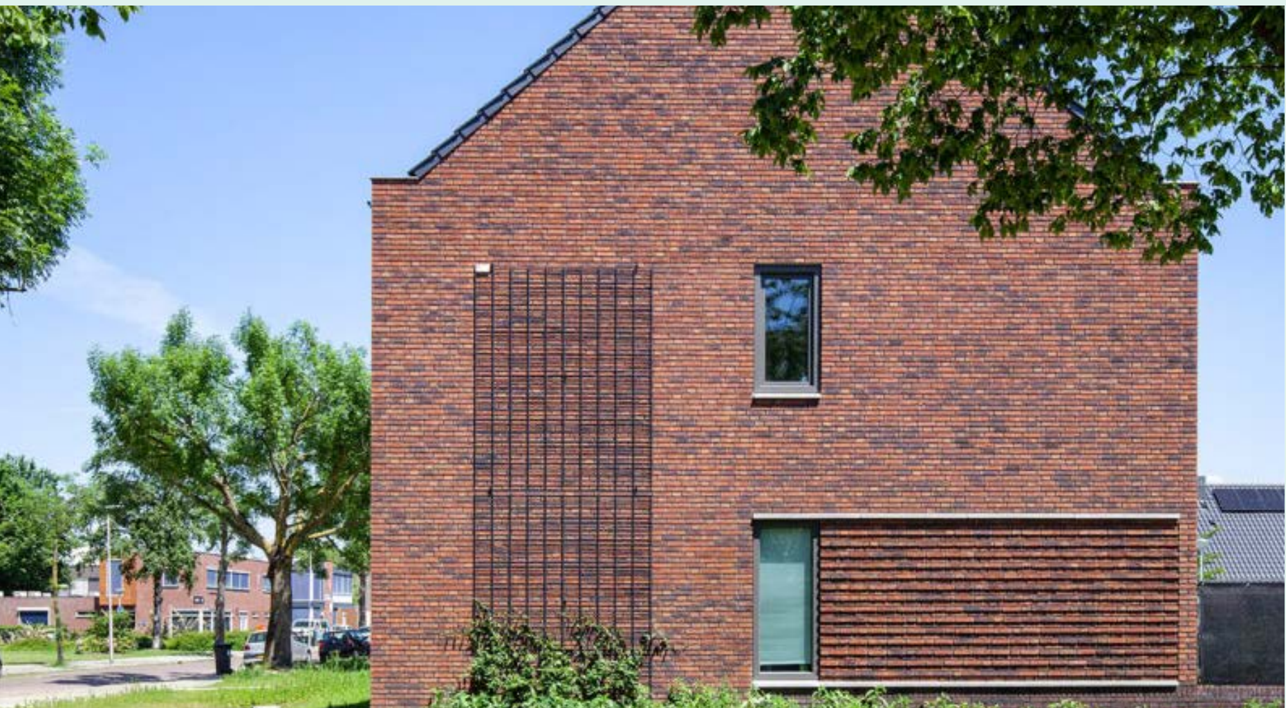
Detail in metselwerk
